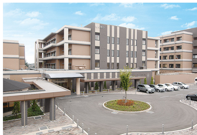
【特別養護老人ホーム もくせい】 玄関前はロータリーがあり、駐車場も完備しています。
