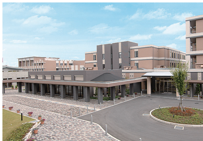
【救護施設 もくせい(奥)】 あかつきホール(地域交流スペース)は、手前の平屋建物になります。
